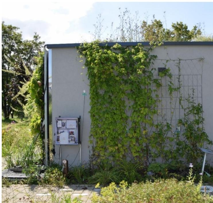
Abbildung 6: Ostfassade mit bodengebundener Fassadenbegrünung (links Hopfen, rechts Geißblatt) und Referenzfeld an der Klimaforschungsstation des CAE in Würzburg.
